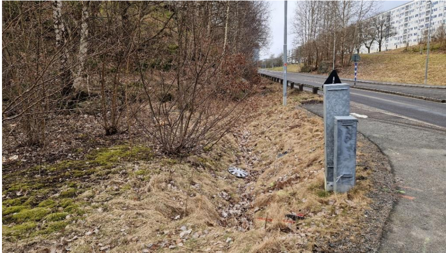
Figur 13. Läge torrdamm 3 i norra delen av område A. Dike utmed Gårdstensvägen norrifrån (Foto: Kretslopp och Vatten).
