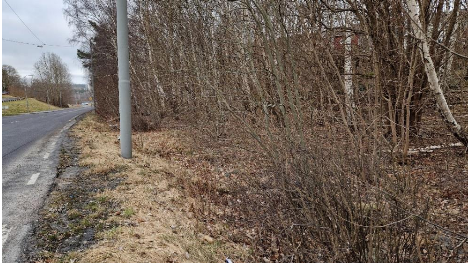
Figur 15. Dike längs Gårdstensvägen söderifrån (Foto: Kretslopp och Vatten).
