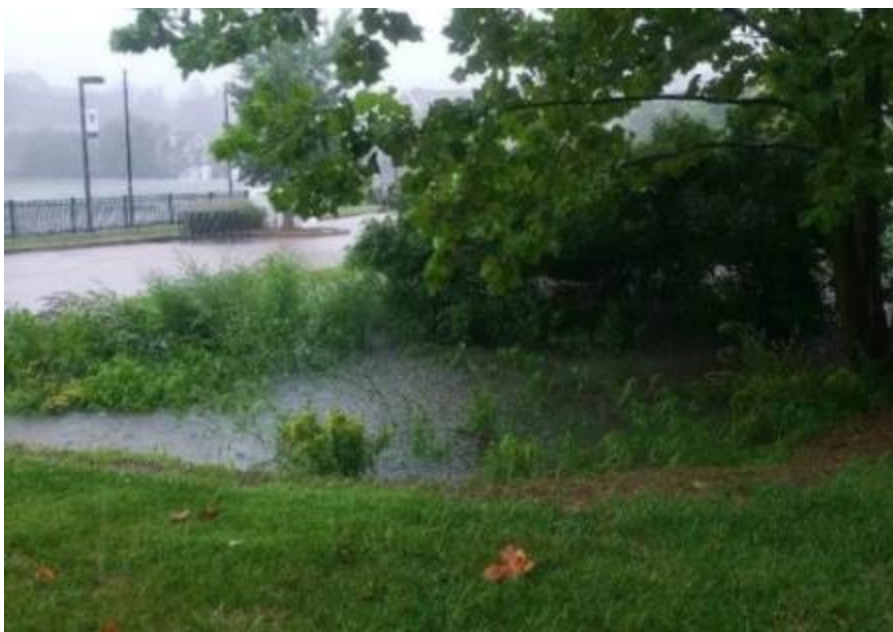
Figur 35. Översvämningssyta intill väg. Foto: Villanova University.
